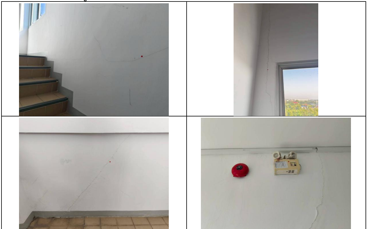
รูปที่ 2-19 รอยร้าวบริเวณผนังอาคารหลังจากเหตุการณ์แผ่นดินไหว
