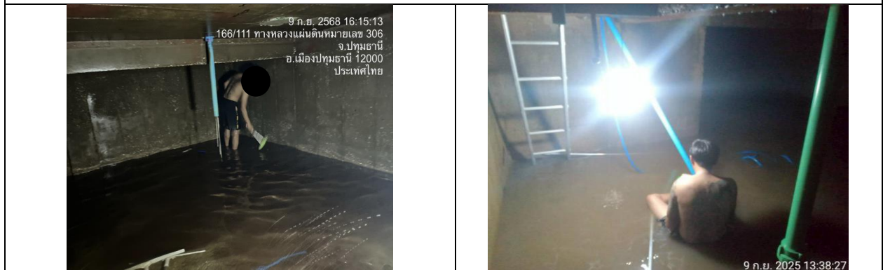
การล้างถังเก็บน้ำสำรองชั้นใต้ดิน
